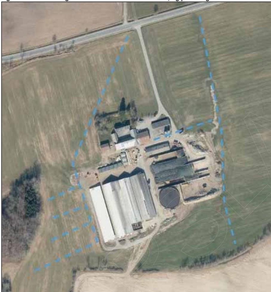
Figur 7. Dræn omkring Olsminde. Kortet er ikke målfast, og placering af dræn er cirka.
